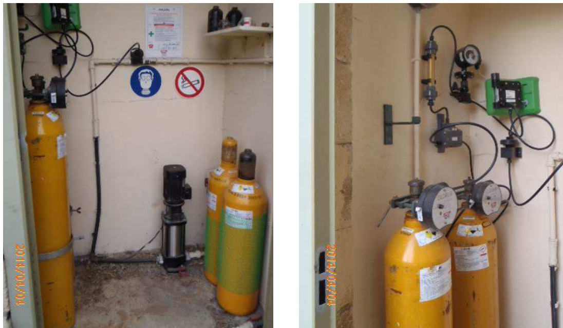
Illustration n°3 : Système de traitement au chlore gazeux
