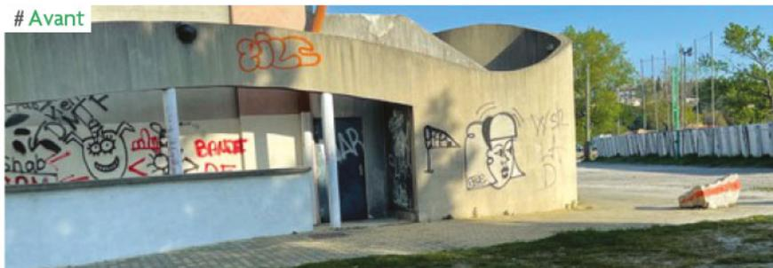
La peinture utilisée pour les graffitis s'imprègne dans l'enduit des façades et un nettoyage à haute pression de type sablage est abrasif pour l'enduit et laisse ainsi des traces définitives. Aussi la commune a engagé le nettoyage des bâtiments tagués par aérogommage.
