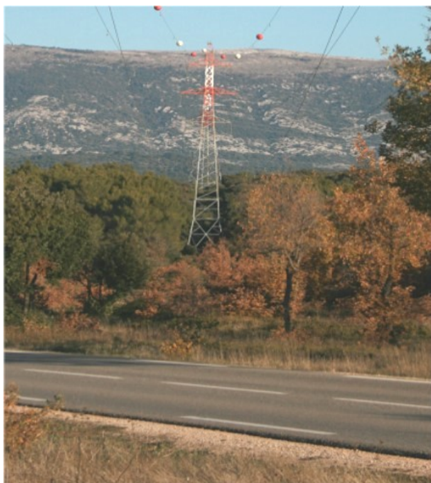
Superposition entre linéaires : route et ligne électriques
